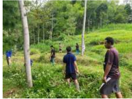
Gambar 14. Proses Pembuatan akses jalan
